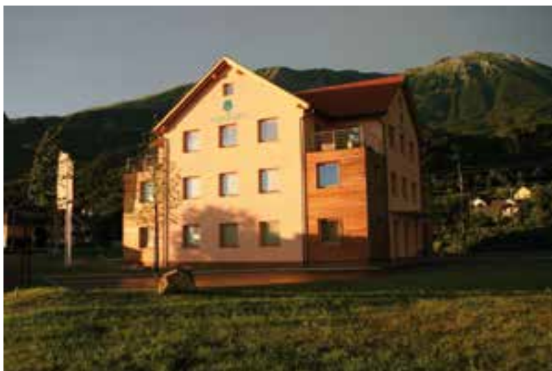
Slika 1: Poslovna stavba podjetja Medium
